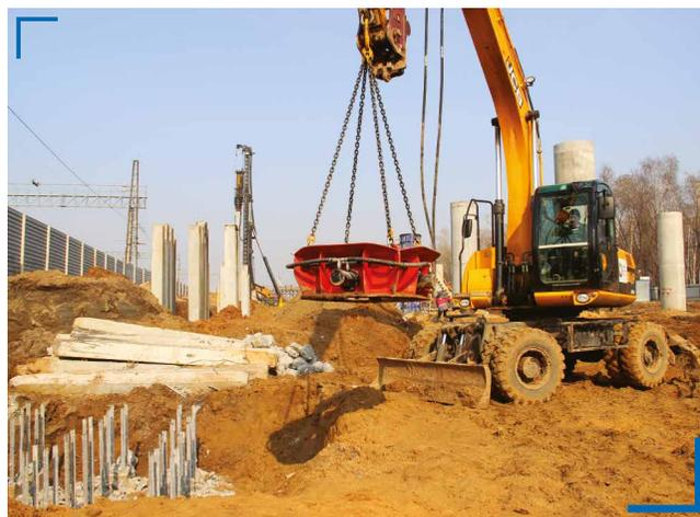
Квадратная сваерезка спроектирована конструкторским бюро Технопарка «Импульс» и предназначена для «обрезки» оголовков железобетонных свай квадратного сечения с сохранением целостности арматуры. Использование квадратных сваескусывателей объективно одно из самых простых, оптимальных по цене и эффективности решений.
